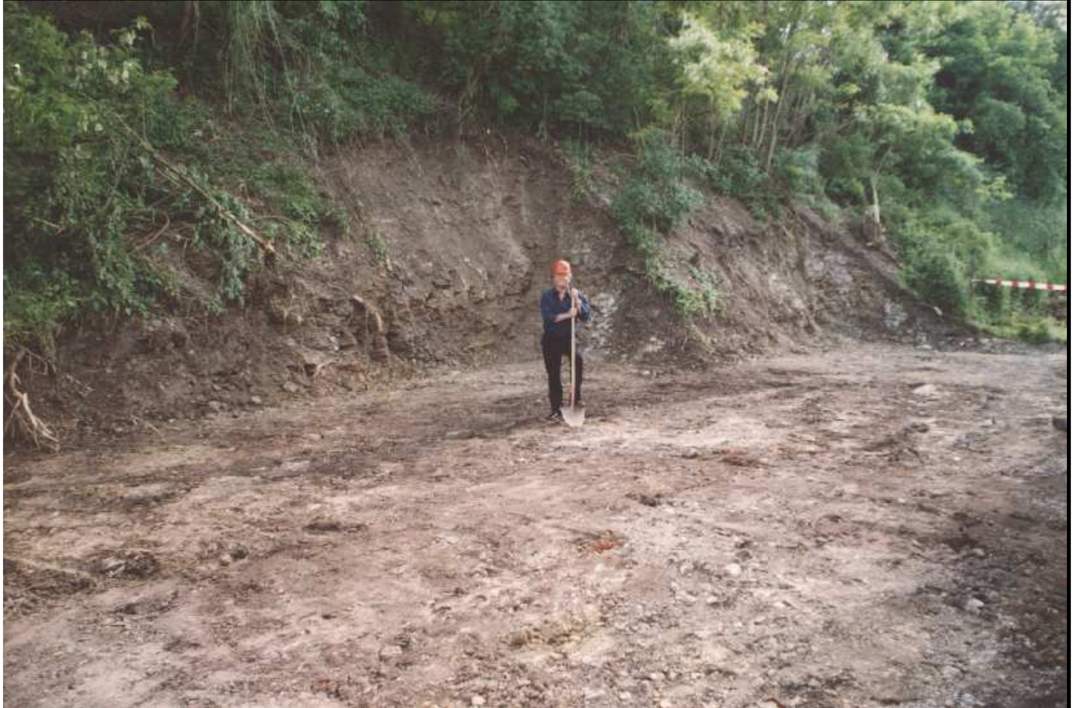
2004 – Helmut Greß in der „Baugrube“
